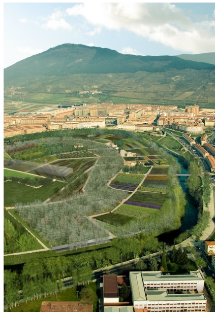
Figura 2 | Pamplona-parque de aranzadi 2009-aldajover arquitectos- il progetto trova un equilibrio tra la qualità degli spazi aperti da restituire alla popolazione e le dinamiche naturali che caratterizzano il meandro fluviale.
