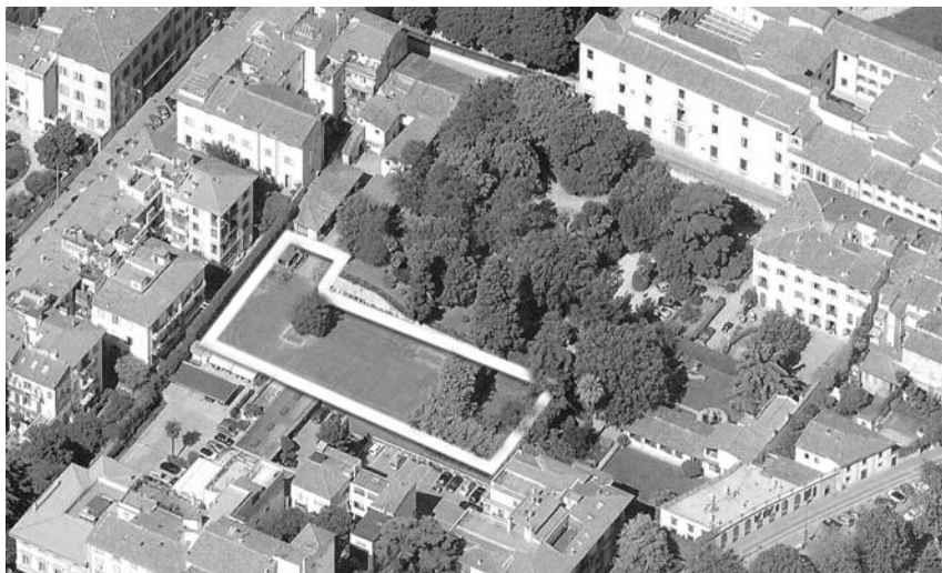
Figura 2 | Vista dall'alto del cortile delle Scuole pubbliche comunali di Borgo Pinti.
