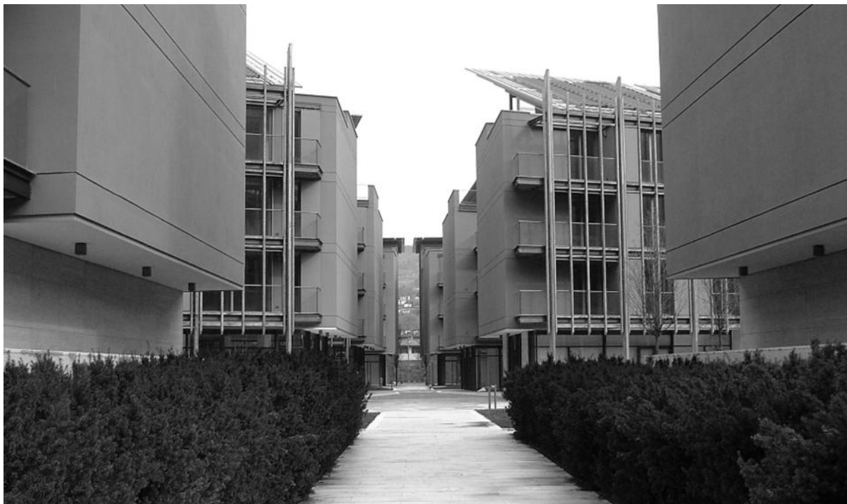
Figura 3 | Quartiere Le Albere. Percorso ciclopeditonale di collegamento tra gli edifici.
