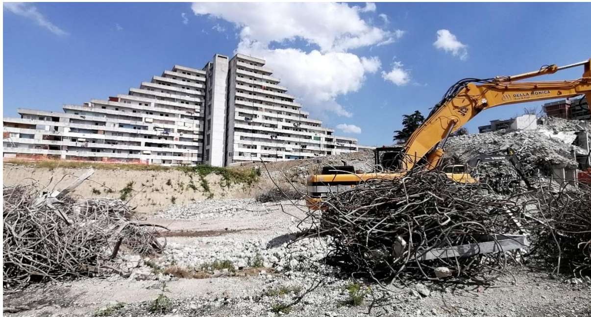
Figura 1 | Demolizione selettiva della ‘vela verde’ (torre A) nel quartiere Scampia di Napoli, 2020. Fonte: foto dell’autrice.
