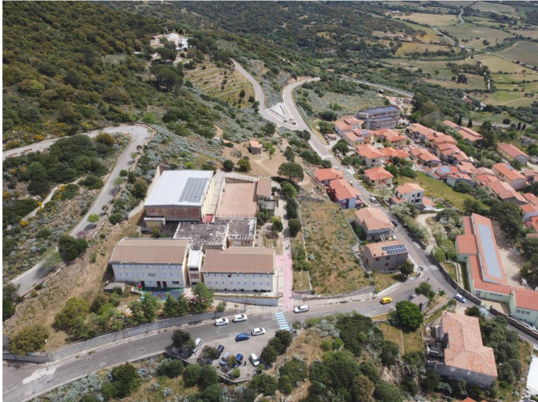
Figura 2 | Berchidda, installazione di pannelli fotovoltaici: in primo piano Scuola Superiore di Primo Grado S.M. P. Casu, sulla destra Scuola dell'Infanzia Via G. Deledda (entrambe parte dell'I.C. G. Elia Lutz - Oschiri). In fondo, sulla sinistra Museo del vino, sulla destra Casa di Riposo per Anziani Maria Bambina (2023).
