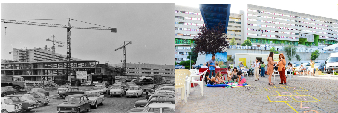
Figura 3 | Corviale in costruzione
