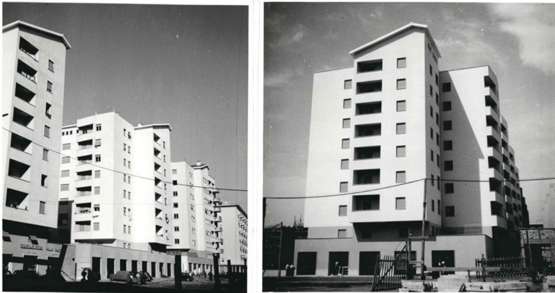
Figura 2. Foto del complesso Inpdai a via Calpurnio Fiamma 33 I/II in costruzione, Roma, anni Cinquanta (Archivio Inpdai)
