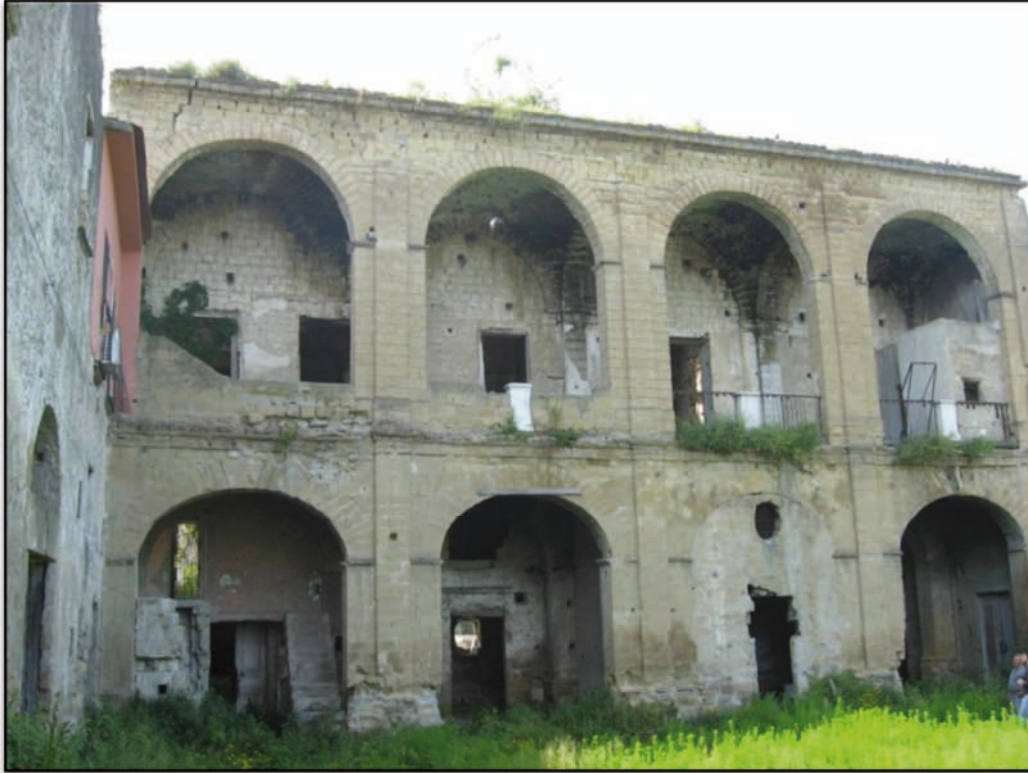
Figura 4. Napoli, Masseria S. Lorenzo (foto M. Falcone 2008): prospetto sulla corte interna.
