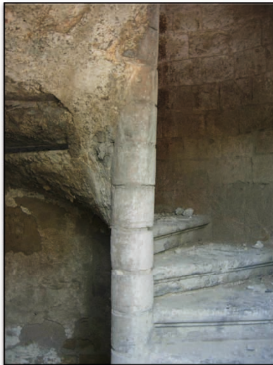
Figura 5. Napoli, Masseria S. Lorenzo (foto M. Falcone 2008): scala a lumaca di accesso al piano nobile.
