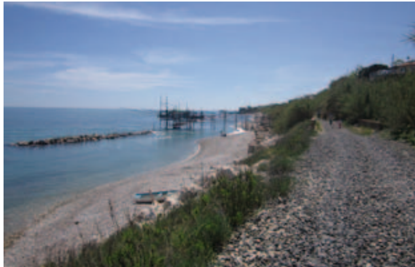
Figura 3. Un tratto del sedime ferroviario dismesso, sullo sfondo i Trabocchi (foto di Roberto Di Monte)
