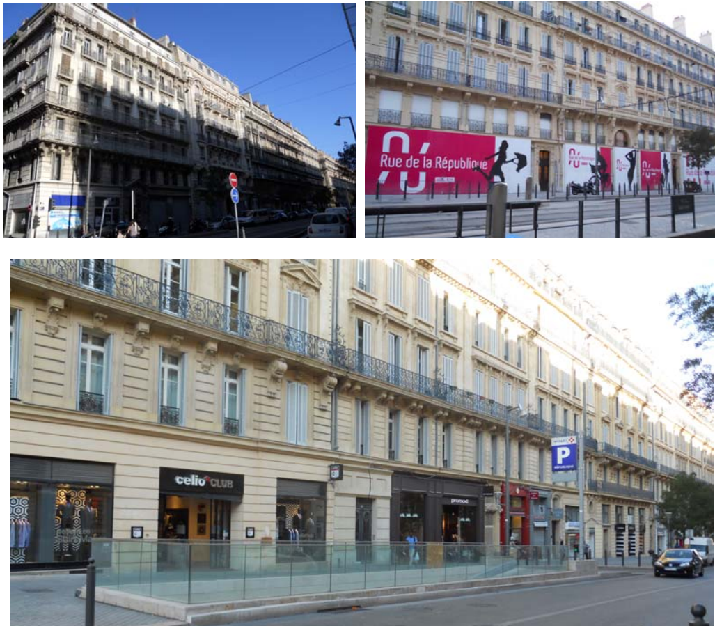
Figure 4. 5. 6. Marsiglia. Rue de la République. Edifici haussmaniani prima, durante e dopo il recupero.
