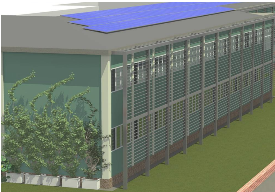
Figura 5. Plesso scolastico. Installazione frangisole fotovoltaico e pannelli fotovoltaici sul tetto.
