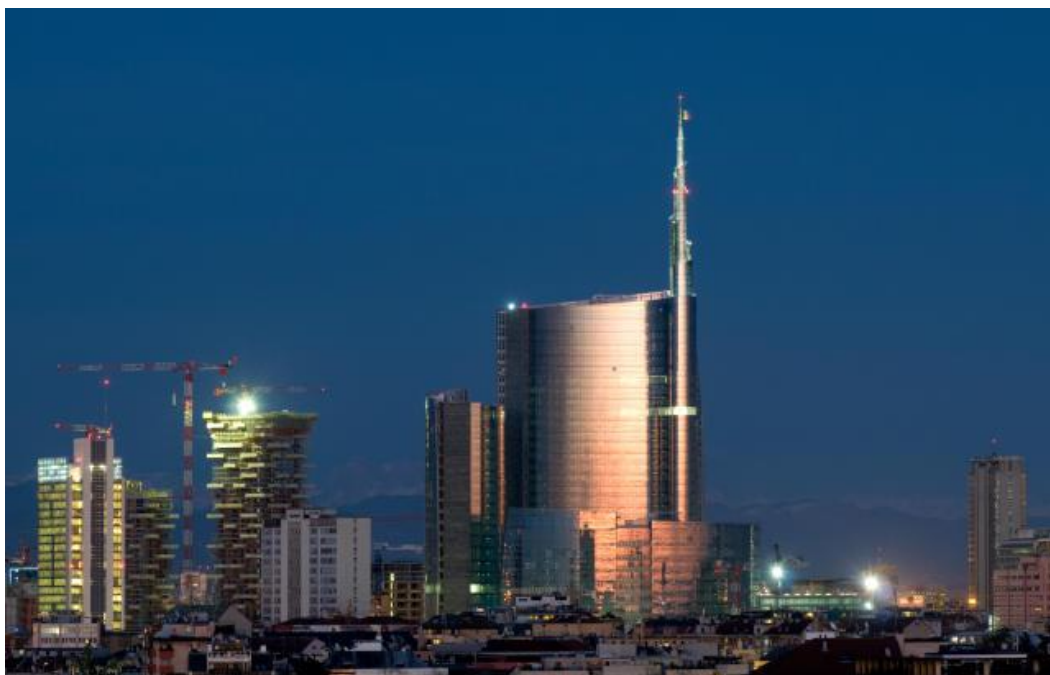
Figura 5. Foto panoramica delle realizzazioni in corso nel P.I.I. Porta Nuova all'ex Centro Direzionale, fonte Stefano Gusmeroli- http://MilanoFoto.it .
