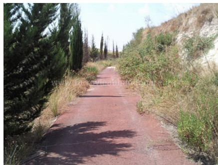
Fig. 7. Ex-fermata di Mulinello, abbandonata e fatiscente, R. Russo, 2011. [Fonte: http://www.ferrovieabbandonate.it/linea_dismissa.php?id=13 ]
