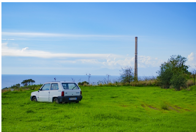
Figura 3 | In foto sventa la ciminiera dell'ex impianto della Liquichimica di Saline Joniche, sulla costa di Montebello Jonico. Un elemento di cancellazione divenuto identitario nel paesaggio. Foto dell'autore.
