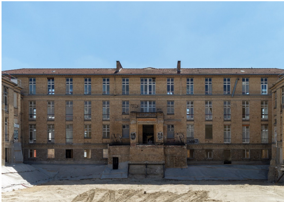
Figura 1 | Edificio Pinard in fase di riabilitazione Fonte: autrice
