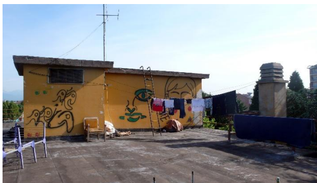
Figura 6 | Vista delle coperture, prima dell'intervento. Fonte: Architettura senza Frontiere Piemonte.
