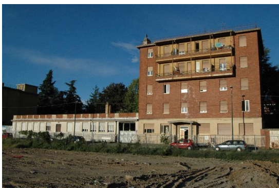
Figura 1 | Vista dell'immobile da via M. de la Salette, prima dell'intervento. Fonte: Architettura senza Frontiere Piemonte.
