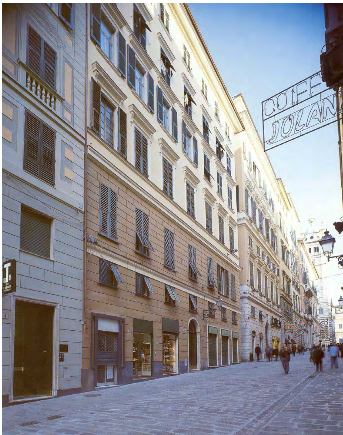
Veduta della via S. Lorenzo a Genova a seguito dei lavori di recupero delle facciate.
