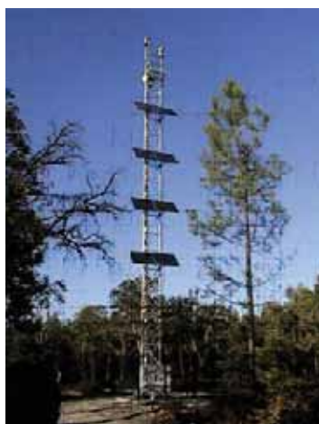
Fig. 1 - Tours de Surveillance et d'acquisition de données
