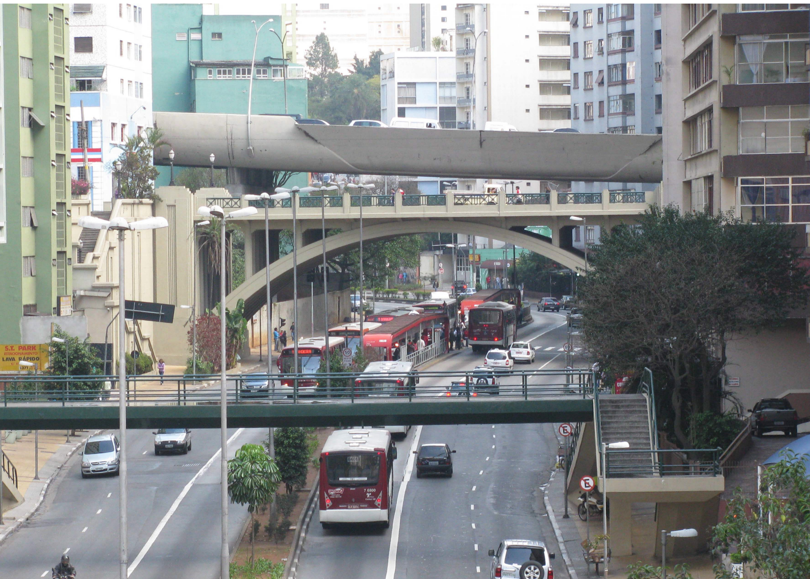
Fig. 9. São Paulo, Avenida 9 de Julho, construída na década de 1940 em um fundo de vale, sobre o córrego Saracura. Na foto pode-se ver a sucessão de viadutos cruzando a avenida em níveis sobrepostos, e o corredor de ônibus construído em 2003. Como está sobre um córrego canalizado, essa área alaga todo ano | it was built in the 1940s at the bottom of Saracura stream valley. In the photo you can see the succession of viaducts crossing the avenue at overlapping levels, and the bus corridor built in 2003. Since it stands on a canalized stream, this area is subjected to floods every year | construíta negli anni 1940 nel fondovalle, sopra il torrente Saracura. Nell'immagine è visibile il susseguirsi di viadotti che si incrociano sulla via a livelli sovrapposti, e la corsia preferenziale degli autobus costruita nel 2003. Poiché è posta sopra ad una torrente intubato, quest'area si allaga tutti gli anni, 2008, © Renato Anelli
