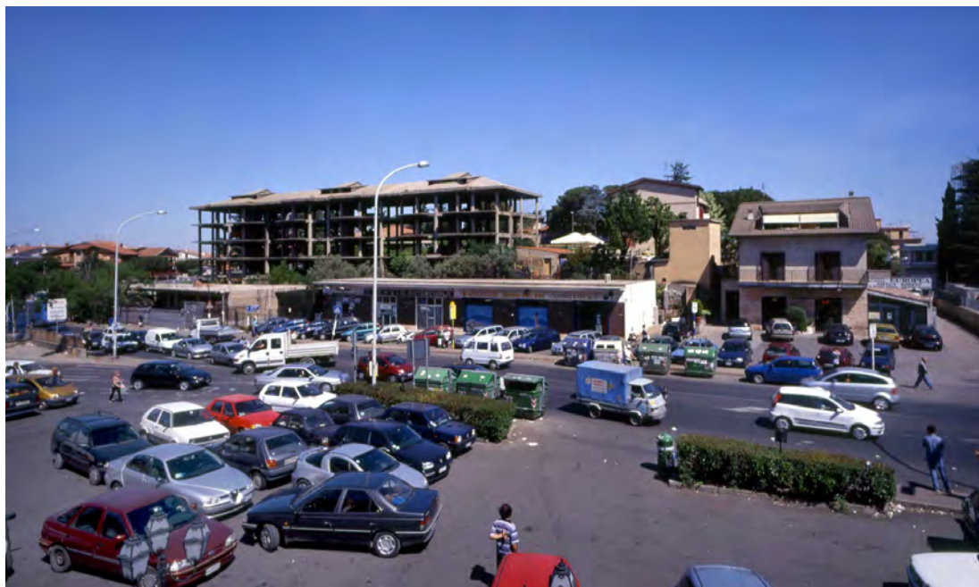
Via Casilina: sullo sfondo la struttura in cemento armato da demolire per recuperare spazi pubblici.
