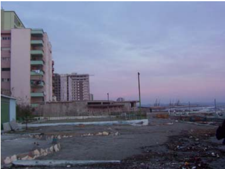
Edifici abusivi sulla spiaggia di Durazzo (foto G.Sergi, 2002)
