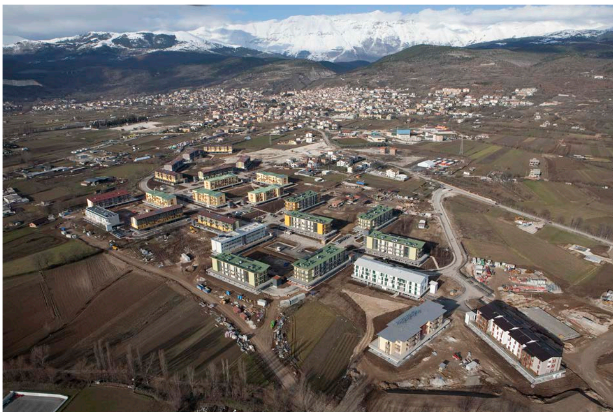
Figura 3. Progetto C.A.S.E. Paganica 2, realizzazione di alloggi emergenziali
