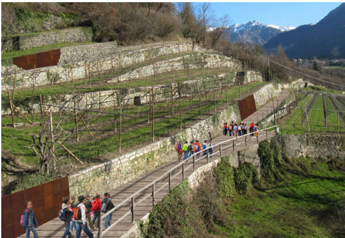
Figura 4. Risarcimento dei muri a secco e creazione di percorsi didattici, sono due delle tattiche previste nella strategia di tutela delle aree di versante.
