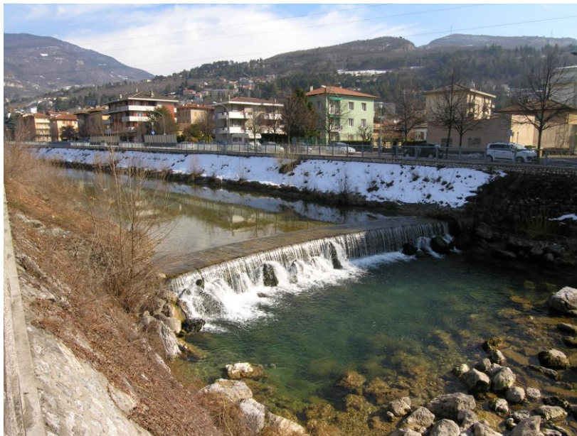
Figura 3. Il Leno, sono particolarmente evidenti le opere di artificializzazione del corso d'acqua e la completa mancanza di vegetazione ripariale. 20 febbraio 2013
