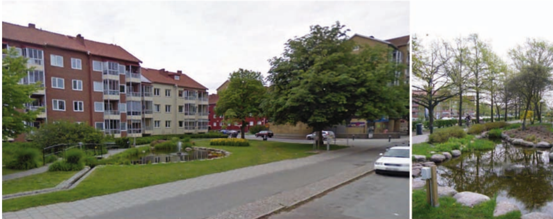
Figura 2. Vista del quartiere Augustenborg a Malmš ed in primo piano il sistema di canalizzazione e di raccolta delle acque, realizzato per adattare il luogo all'aumento della frequenza delle piogge intense e del rischio allagamento.
