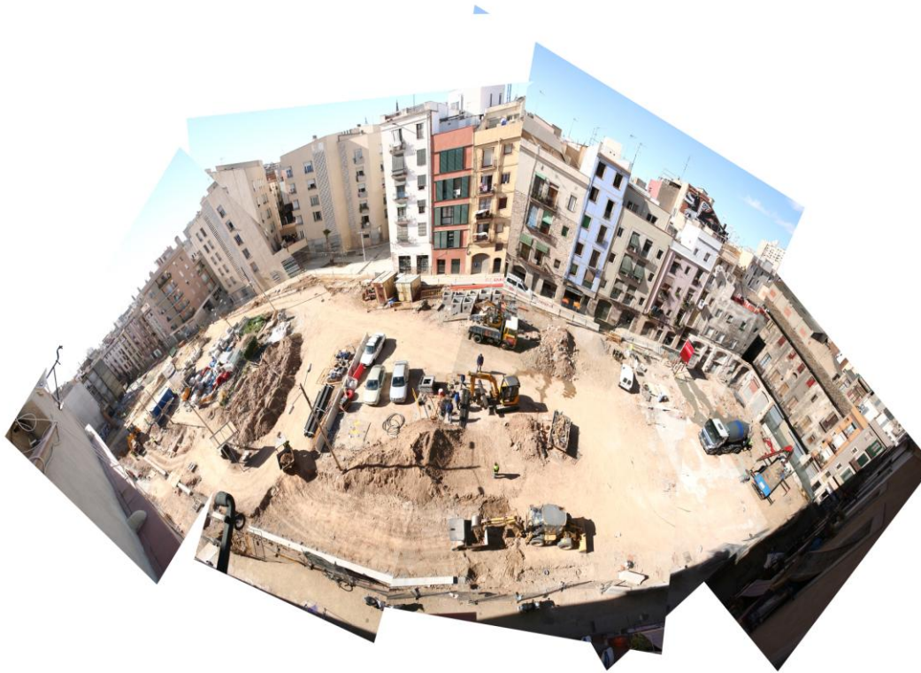
Figura 3. Parc del Pou de la Figuera, lavori in corso
